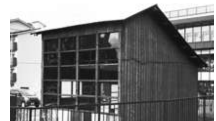
Umgesetztes altes Gebäude der Siedlung für koreanische Zwangsarbeiter Utoro, Uji, Präfektur Kyoto Relocated old building of the settlement for Korean forced laborers in Utoro, Uji, Kyoto Prefecture
